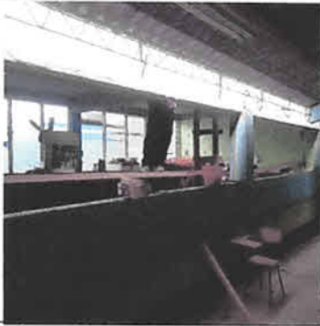
Foto1: Sellado con block en ventanas laterales.
