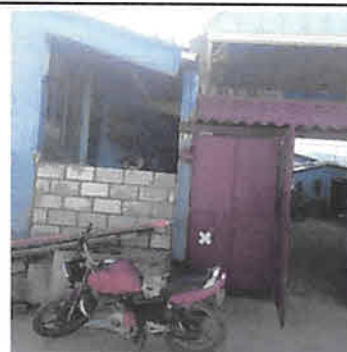
Foto 4: Sellado en muro perimetral con block de 0.15 con repello y cernido.
